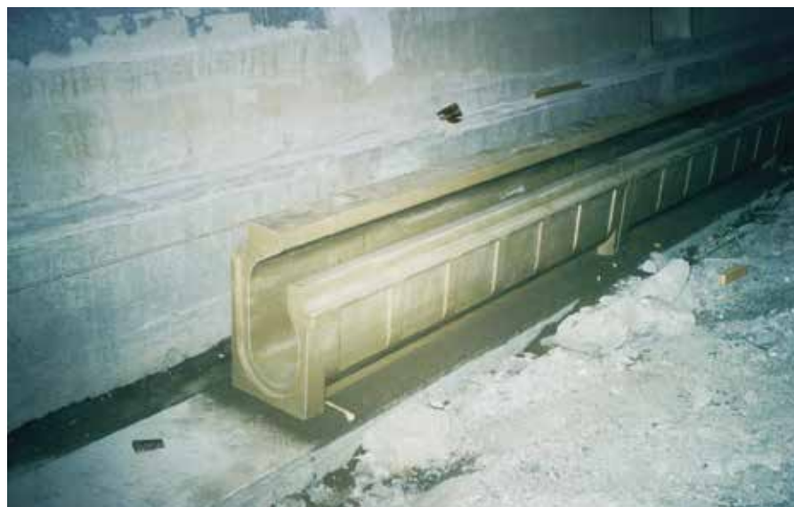
Fase di posa dell'elemento a fessura con alta capacità di smaltimento
