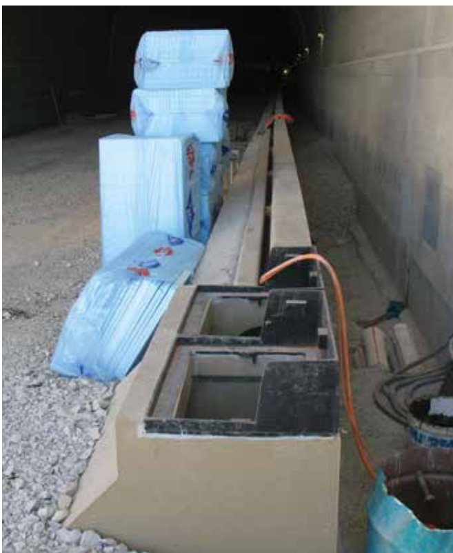
Il pozzetto tagliafiamma in calcestruzzo polimerico
