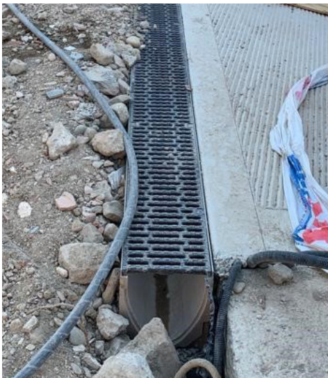
In alto: a sx, particolare della posa dei canali Multiline lungo una rampa; a dx, il lavoro finito
