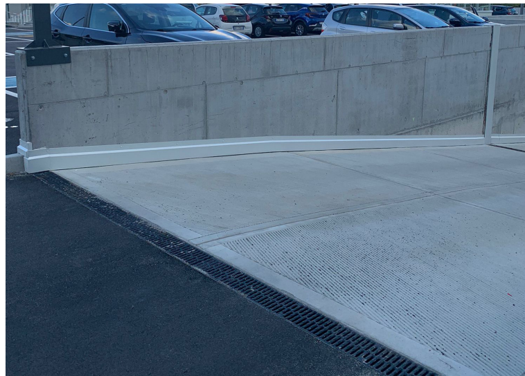
In alto: a sx, particolare della posa dei canali Multiline lungo una rampa; a dx, il lavoro finito
