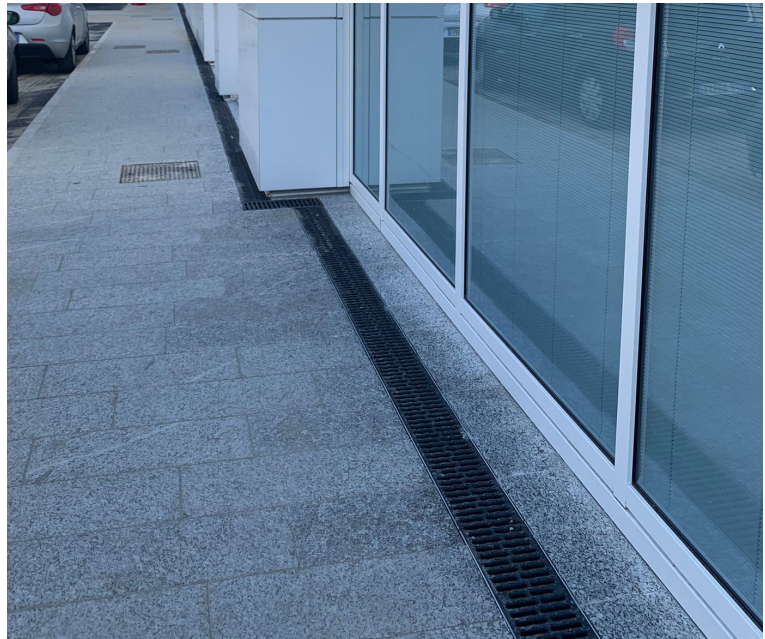
In alto e in basso: basamento del nuovo ospedale lungo il cui perimetro corrono i canali ACO.
