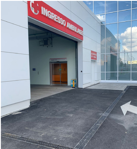
In alto: canali Multiline V150 installati in prossimità dell'ingresso e dell'uscita del pronto soccorso.
