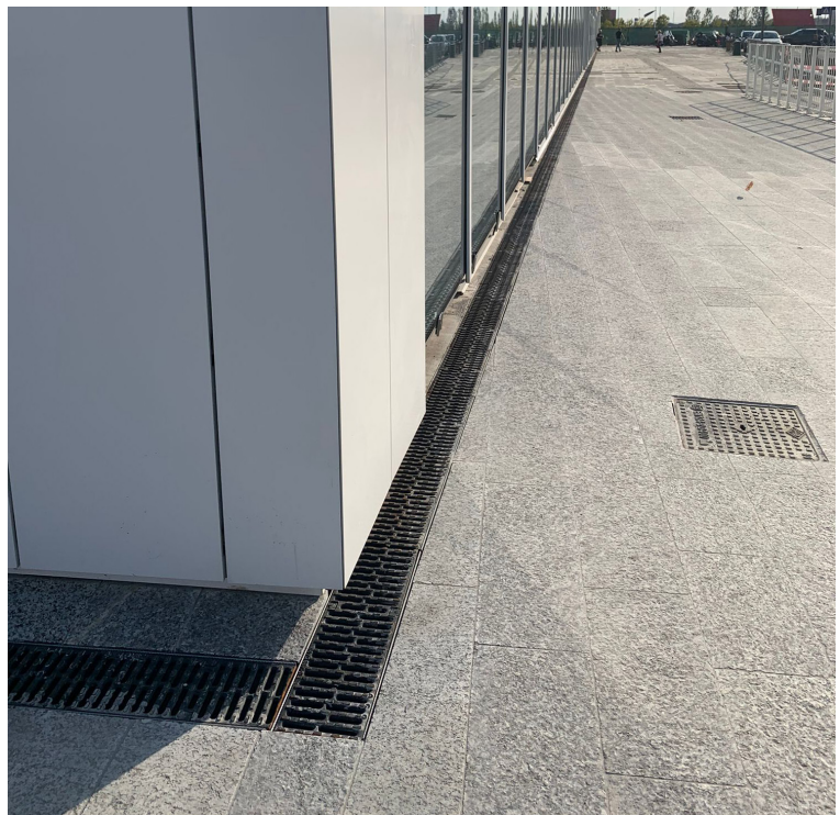
Canale Multiline V150 con griglia in ghisa
