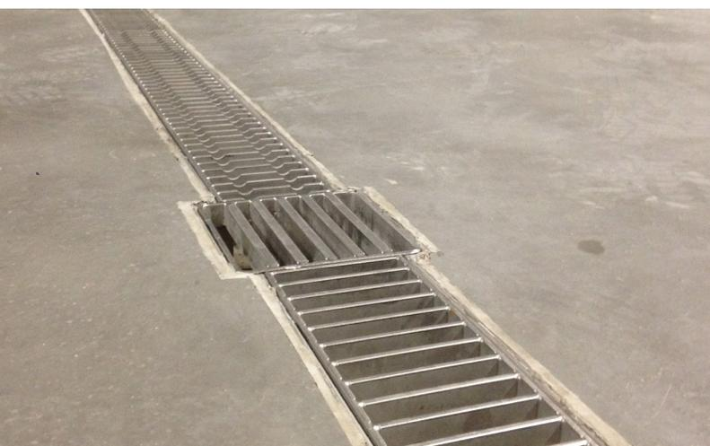
Particolare della linea di drenaggio; è possibile riconoscere: le griglie a barre ACO carrabili e con design antiscivolo poste sia sul canale sia sul pozzetto.
