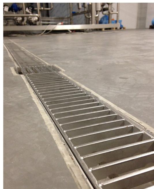
Canali in acciaio inox ACO Box 125 con griglia di copertura a barre carrabili all'interno dello stabilimento Menz & Gasser.
