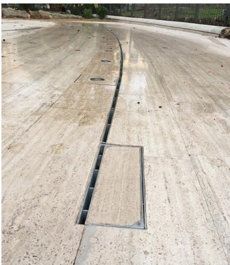
*A sx: particolare dell'elemento d'ispezione lungo la linea di drenaggio in prossimità della Fontana degli Zampilli*
