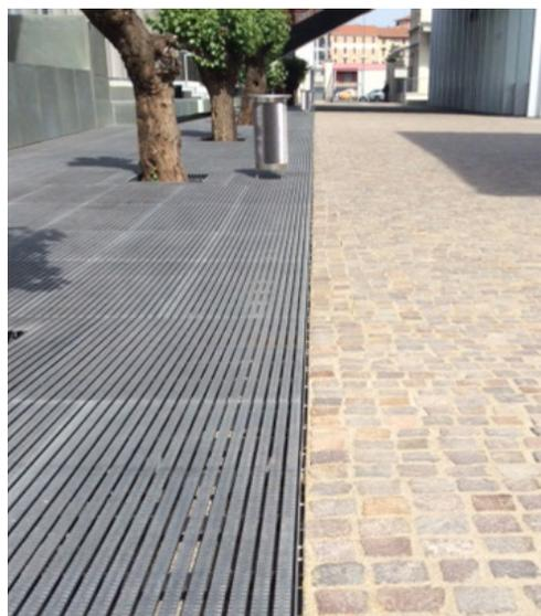
Finitura con caditoia a fessura in acciaio inox con canale ACO Multiline sottostante. Elementi lineari posati tra due pavimentazioni differenti, porfido e drenate con barre in acciaio.
