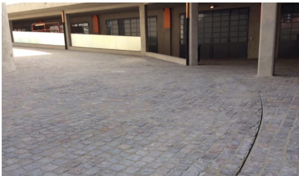
Canale a fessura in acciaio inox calandrato con raggio di curvatura secondo progetto su pavimentazione in blocchi di porfido.
