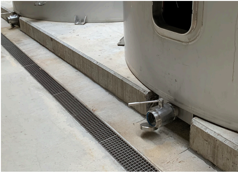
In alto: canali ACO Box 200 nell'area di affinamento esterna.
