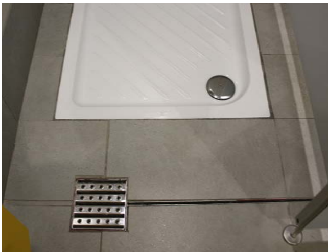
In alto a sx e a dx: canali a fessura ACO Slot 8 nell'area spogliatoi e vani doccia.
