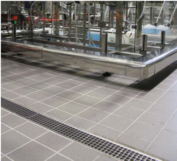
In alto e a lato: canali ACO Box 125 nell'area di affinamento in acciaio.
