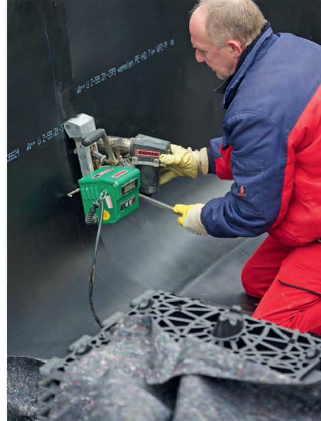
La membrana impermeabile viene termosaldata
