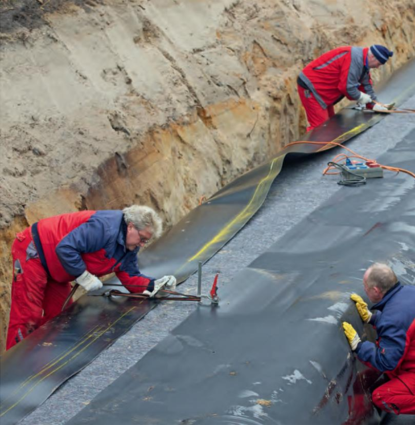
Il sistema di stoccaggio è avvolto con uno strato di tessuto protettivo interno e una membrana impermeabile di tenuta
