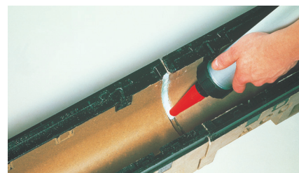
Fase 3 - Sigillatura canale
