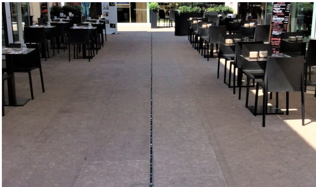
Linea di drenaggio ACO davanti a un punto di ristoro
