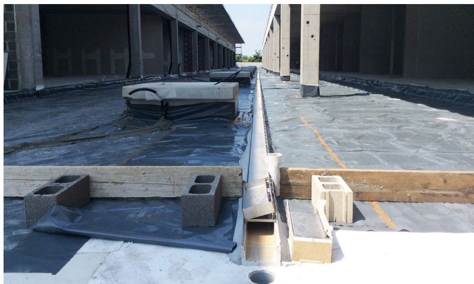
Fasi di posa
