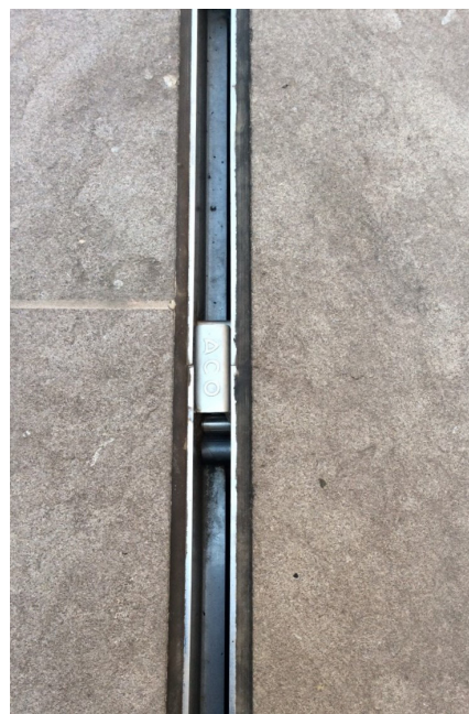
Particolare della caditoia a fessura
