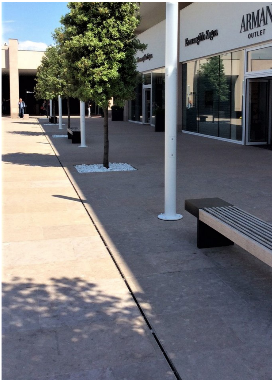
Linea di drenaggio ACO lungo la promenade
