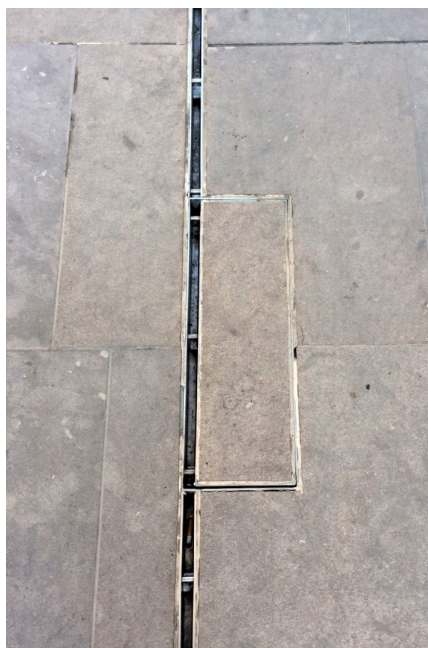
Particolare dell'elemento d'ispezione
