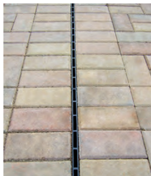
Esempio di posa di Hexaline con caditoia a fessura, ideale per un sistema economico di drenaggio a fessura in ambito residenziale.
