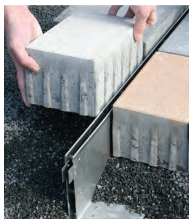
Fase di posa di canale Aco V Self con caditoia a fessura
