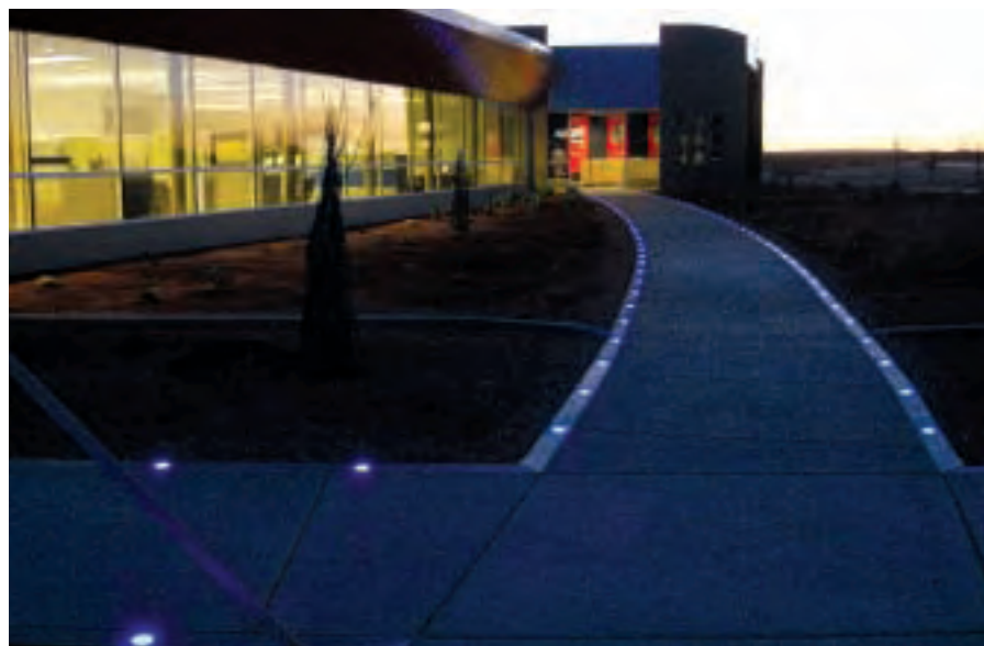
Drenaggio con led Lightspot per la nuova sede ACO di Casa Grande - USA
